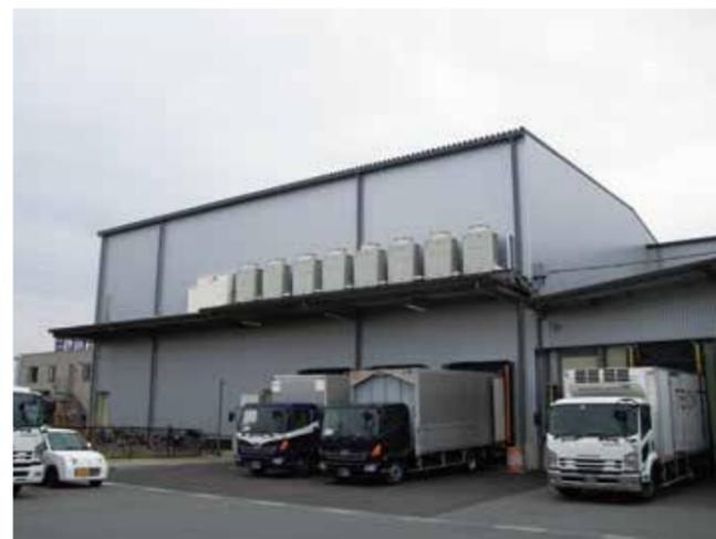
▲一体空冷式インバータコンデンシングユニットは、東棟1階底上に集中設置
